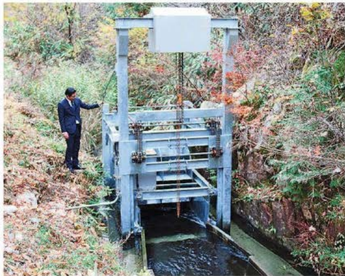
整備された「津山市桑谷エリス発電所」
